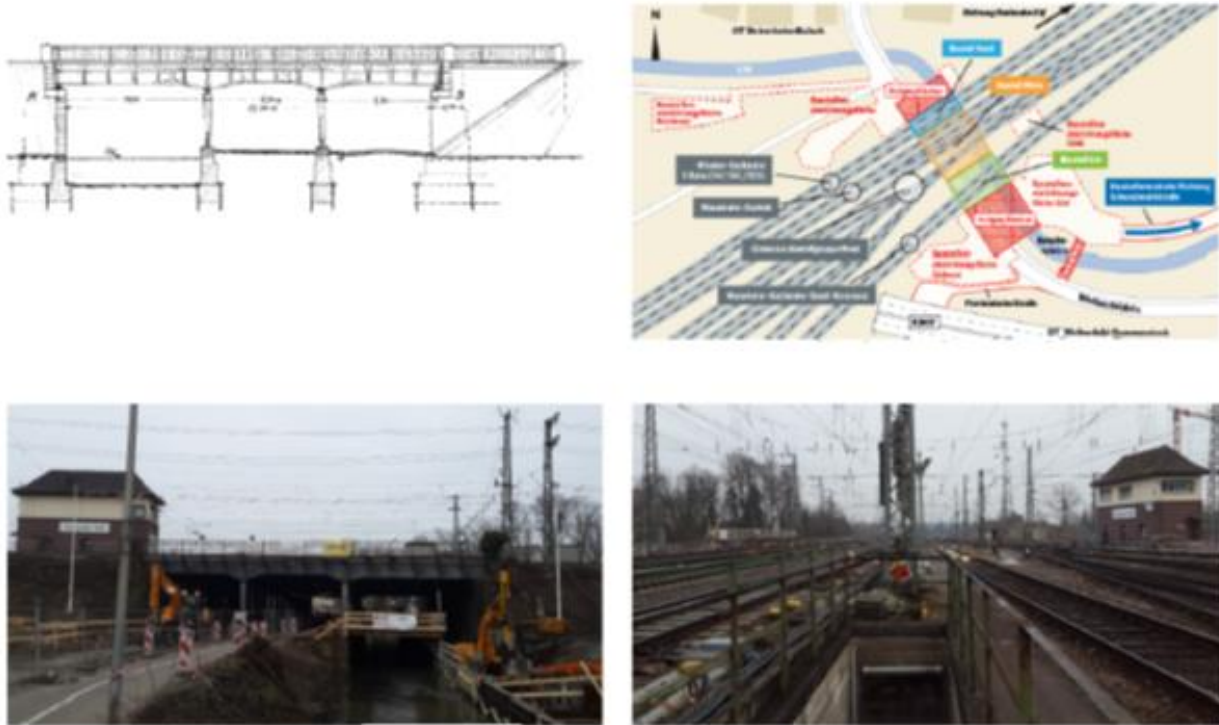
Şekil 7. Weiherfeld köprüsü enkesit, plan ve köprü yenileme çalışmaları
